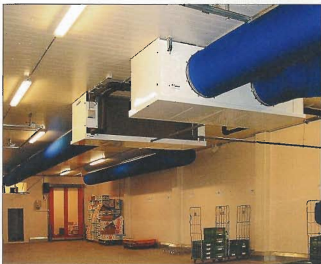
Afbeelding 5 – Verdampers met luchtverdeelerslangen
