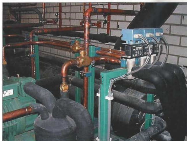
Afbeelding 4 – Expansieventielen en warmtewisselaar
