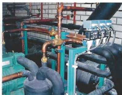
■ Expansieventielen en warmtewisselaar
